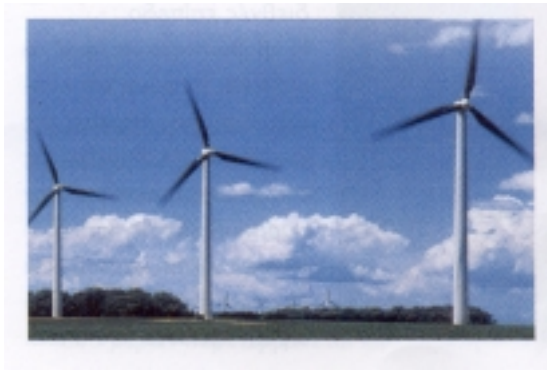
Σχήμα 2. Αιολικός Σταθμός Παραγωγής
